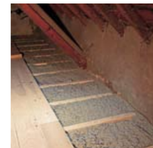
Dämmung oberste Geschossdecke
