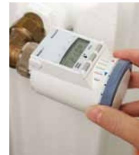
Vous pouvez installer des **vannes thermostatiques** sur les radiateurs existants pour réguler la température de la pièce. Les vannes thermostatiques électroniques sont une solution particulièrement intéressante, permettant de contrôler la température dans différentes pièces d'après un plan horaire défini.
