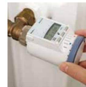
**Thermostatventile** können an bestehenden Heizkörpern nachgerüstet werden und regeln die Raumtemperatur. Sehr praktisch sind elektronische Thermostatventile, mit denen die Temperatur in den unterschiedlichen Räumen gemäß einem Zeitprogramm gesteuert werden können.
